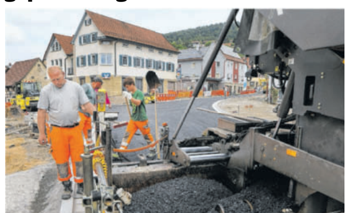
Bauarbeiter asphaltieren die Geislinger Straße. Foto: Ufuk Arslan
